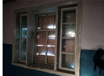
Фото 9. Объект культурного наследия «Дом жилой» (г. Тобольск, ул. Пушкина, 38). Интерьер объекта. Второй этаж. Фото 2022 г.
