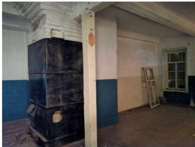
Фото 8. Объект культурного наследия «Дом жилой» (г. Тобольск, ул. Пушкина, 38). Интерьер объекта. Второй этаж. Фото 2022 г.
