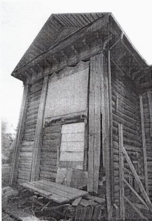
Фото 2. Объект культурного наследия «Дом жилой» ( г. Тобольск, ул. Семакова, 13). Вид на дворовый лестничный пристрой объекта. Фото 2025 г.
