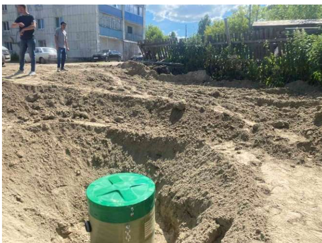
Ремонт септиков с подводщими трубопроводами сетей водоотведения МКД 10 септиков
