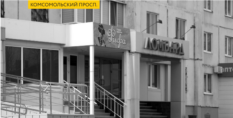
Над входом устроен козырек
