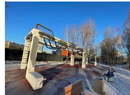
Устройство Ниндзя парка - в 10 мкр.
