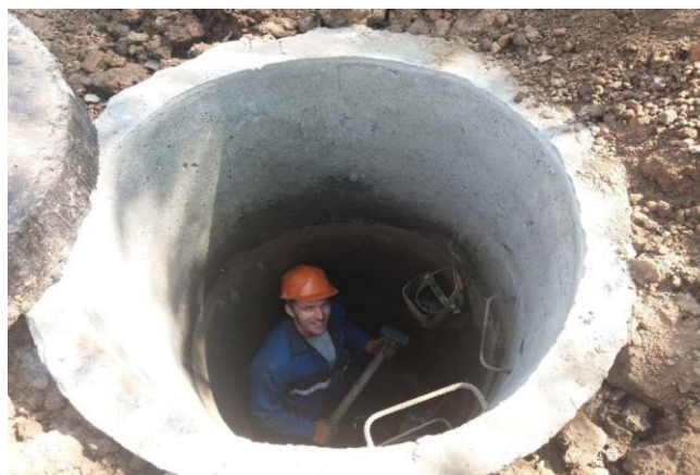
Ремонт септиков с подводными трубопроводами сетей водоотведения МКД 10 септиков
