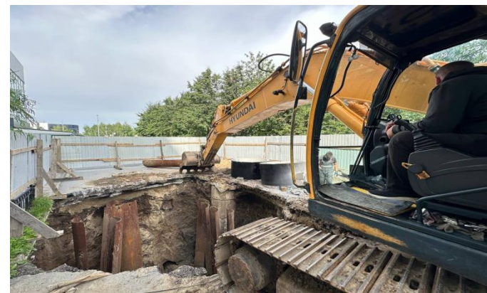
Ремонт сетей водоотведения 207 м
