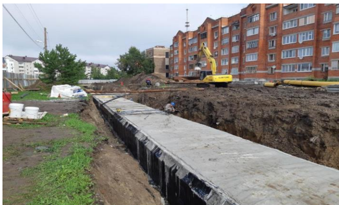
Ремонт сетей теплоснабжения 512,8 м
