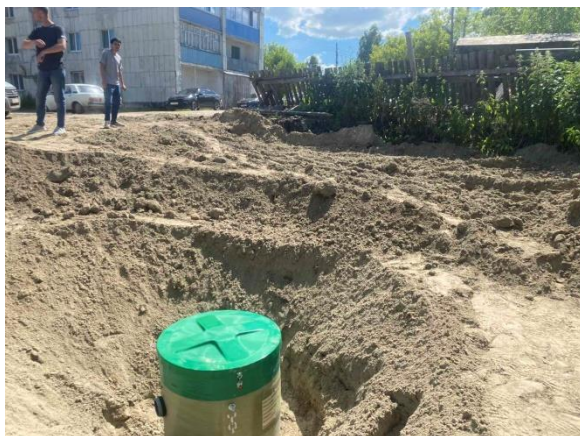
Ремонт септиков с подводщими трубопроводами сетей водоотведения МКД
