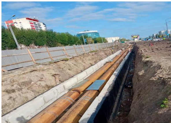
Ремонт сетей теплоснабжения
