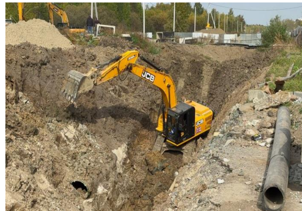
Ремонт сетей водоотведения
