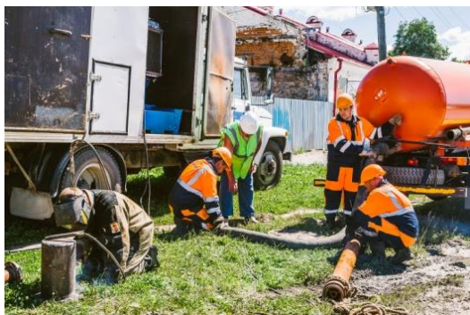
Ремонт сетей теплоснабжения 3 252 м
