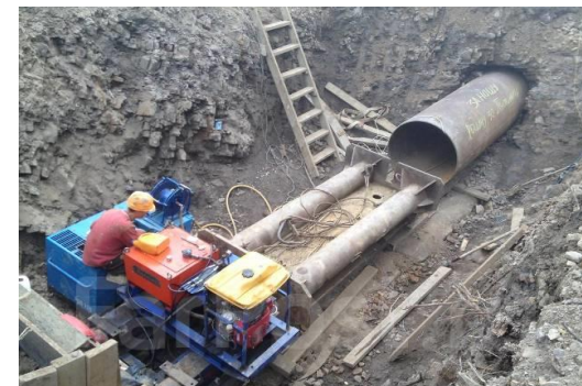
Ремонт сетей водоотведения 653,85 м
