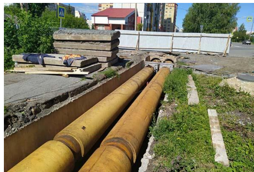
Строительство сетей водоснабжения 8 813 м
