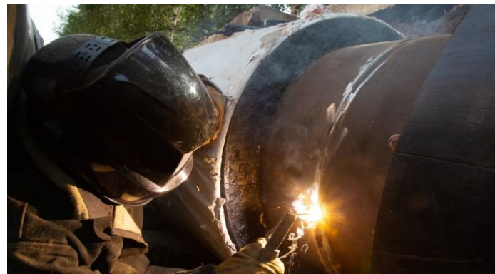
Ремонт сетей водоотведения – 1488,82 м
