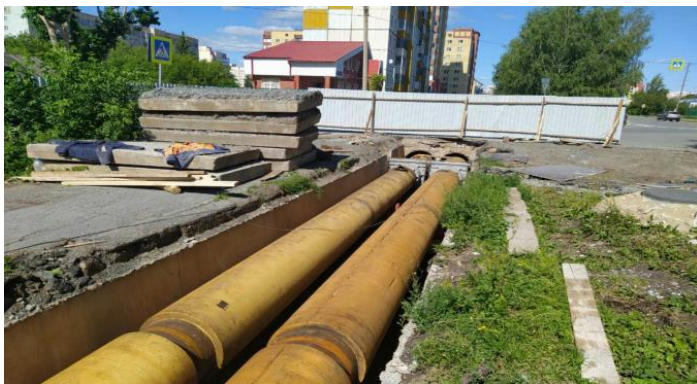
Ремонт сетей теплоснабжения – 429,5 м
